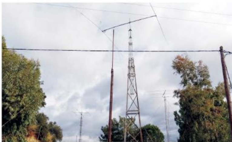
Η beam για τα 40 m δεσπόζει στο χώρο του σταθμού.
